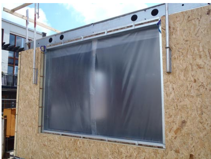
17. Raamopening in een Star-Frame wand.
