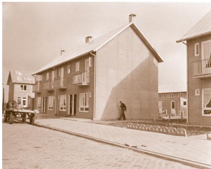
60. De woningen van Polynorm in Eindhoven (1951), gebouwd in staalframesysteem.
