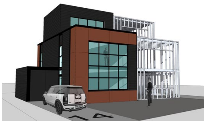
1. Staalframewoningen in project Zonne Entree, Apeldoorn.
