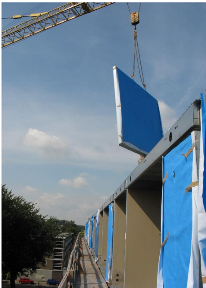
4. Optoppen van een galerijflat in project Het Lage Land, Rotterdam.
