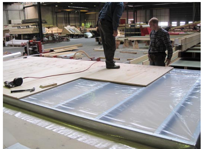
38. De h.o.h.-afstanden zijn o.a. afhankelijk van het plaatmateriaal.
