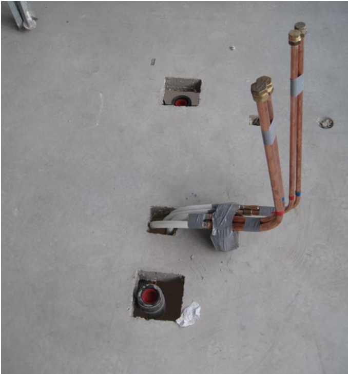
28. Diverse doorvoeren t.b.v. badkamer.
