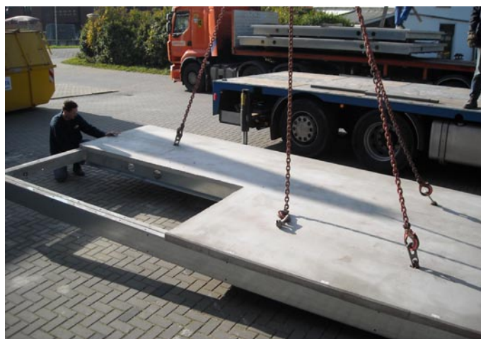
25. Trapgatsparing in een Quantum Deck vloer.
