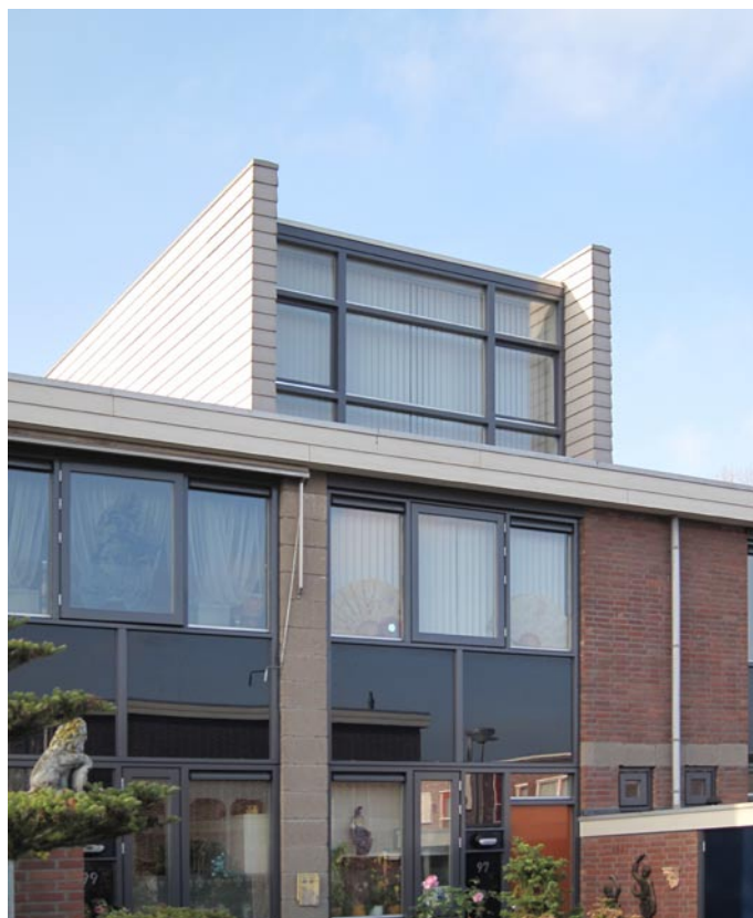
2. Extra verdieping in staalframe in woonwijk Hordijkerveld, Rotterdam.
