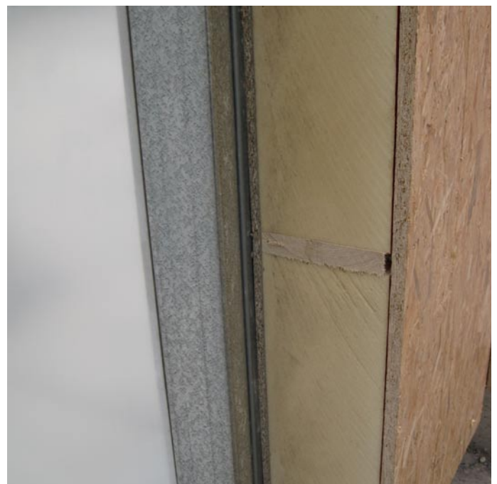
49. Star-Frame wand met aan de buitenzijde een sandwichpaneel met 160mm PIR-isolatie ( R_c = 7 \text{ kW/m}^2 )
