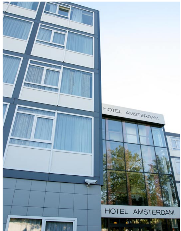
5. Nieuwbouw HEM Hotel Amsterdam.
