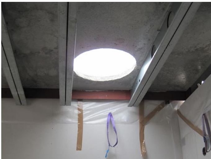
23. Ronde sparing t.b.v. daklichtkoepel.
