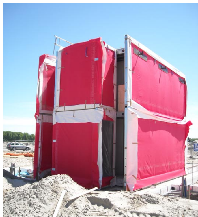
52. Star-Frame wanden voorzien van dampen/waterwerende folie
